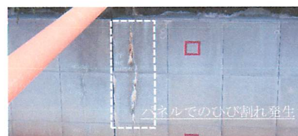
(c) パネル被覆工法による施工例（ひび割れ発生区間）
