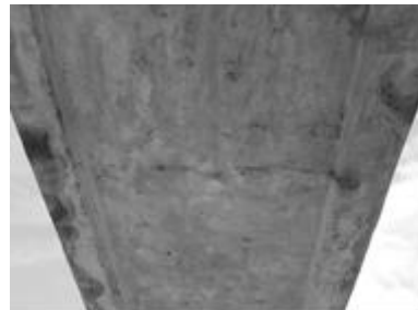
(b)水路橋底板部のひび割れ損傷
