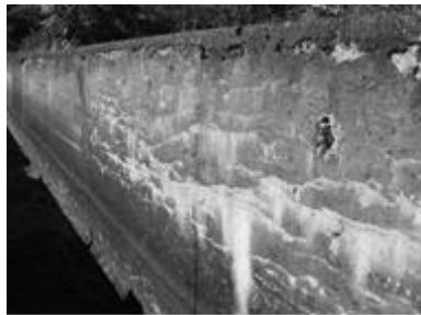
(a)側壁部のひび割れ損傷
