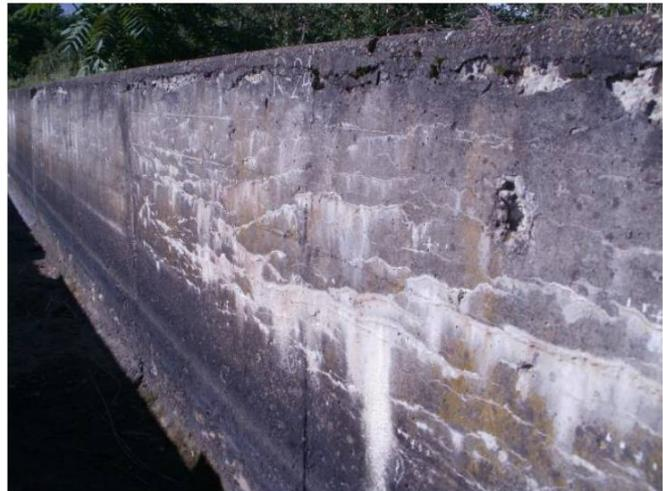
写真-1 凍害損傷が顕在化した用水路
